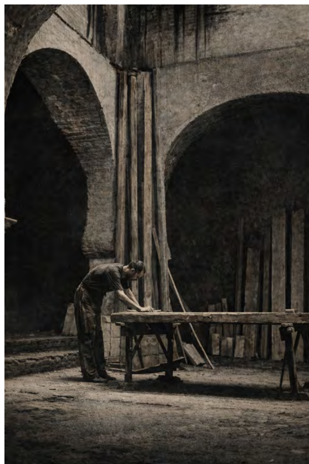
Carpintería en el interior de los Baños. Murcia Sindical 7 de septiembre de 1952.
